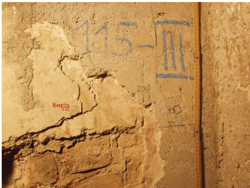
Obr.19. Nálezová situace v sondě zachytila souvrství, zároveň vyhodnocované restaurátorskou zprávou. Výhodou je tedy popis přímo na omítku. Na záběru je také zřetelné zakreslení vodorovné srovnávací roviny (váhorysu). Pomáhá jasně definovat výškopisný vztah jednotlivých dílčích nálezů. Souvrství zachycuje svrchu od recentní opravy omítky až po spárované cihly cihelného skeletu z poloviny 14. stol. (Praha, Havelský trh č. p. 509, sonda v 1. patře v někdejší velké síni.)
