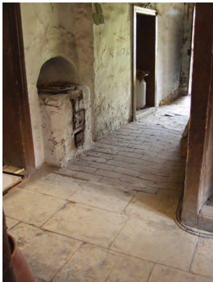
Obr. 21. Příklad fotodokumentace dlažby v předměstském domě č. p. 93 ve Vysokém Mýtě. Hodno zaznamenání do půdorysu je rozhraní kamene a cihel. Intenzita proslapání je indicií intenzity provozu. Kromě toho zde je zachován i vytápěný prádelní hrnec, patrně z 1. pol. 20. stol. (viz kap. 10. 5. 4., technické vybavení).
