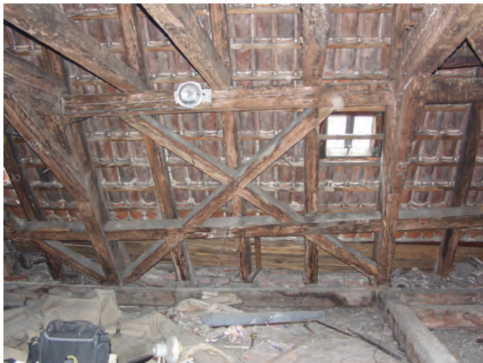
Obr. 28. Charakteristický způsob opravy krovů v 19. stol., uhnídlá zhlaví ve spoji krokve, vazný a zároveň stropní trám je uřezán a je podvlečen úsporný rošt vazných trámů a výměn s krátkčaty. Praha, Havelský trh č. p. 509. Raně barokní krov, dendrodatovaný 1631, oprava 1826.
