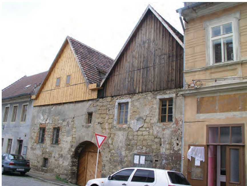
Obr. 11. Předměstský dům č. p. 18 v Ústěku svým hmotovým uspořádáním a rozvrhem otvorů na první pohled prozrazuje pozdně středověký původ.
