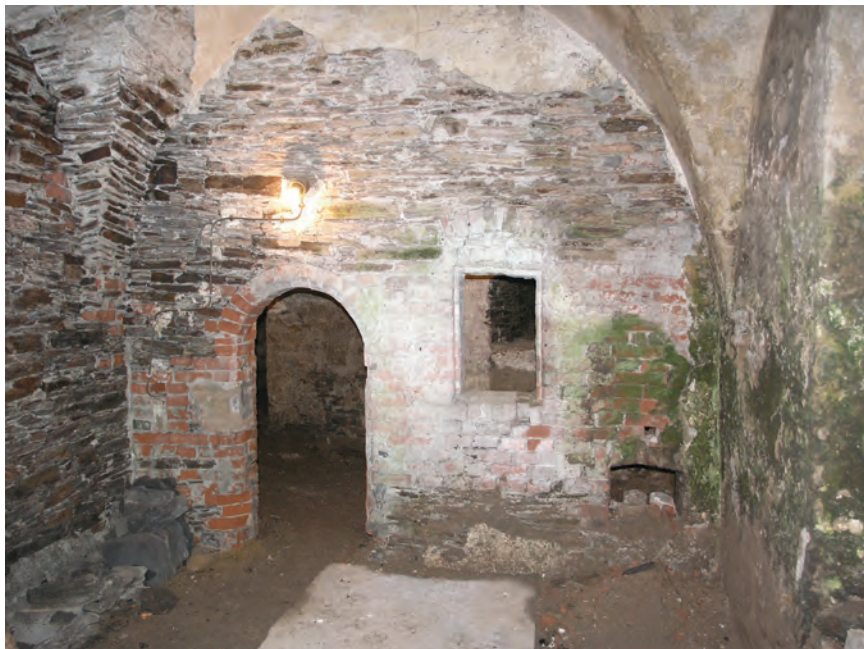
Obr. 17. Jáchymov č. p. 127, dnes fara. Dílna s ohništěm v polosuterénu domu byla součástí vybavy domu v době vzniku. Přístup vedl jak šíjí z ulice, tak schodištěm v síle zdi z přízemí domu.
