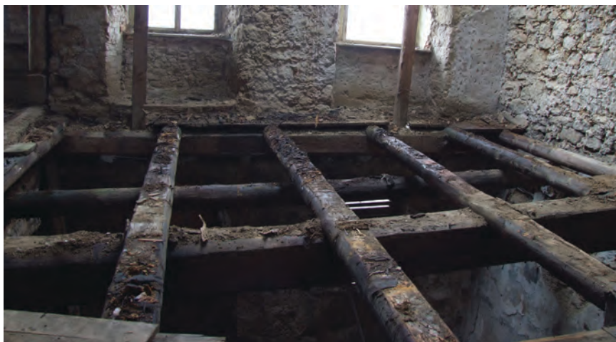
Obr. 23. Bělá pod Bezdězem č. p. 87. Netypický strop nad světnicí v přízemí ze 17. stol. byl tvořen velkým středovým průvlakem a k němu u zdi po jednom přístěnném trámu či průvlaků. (Na obrázku zleva doprava) Na nich byly povaly. Při klasicistní úpravě byl poval odstraněn a osazeny nepravé stropní trámy (jsou to zároveň polštáře) ve směru kolmém na průvlak. Zespodu byly přidány rákosníky ve shodném směru se starším průvlakem a přitom vše opatřeno podhledem. Světnice v přízemí byla dále užívána k pronájmu, např. jako pošta.
