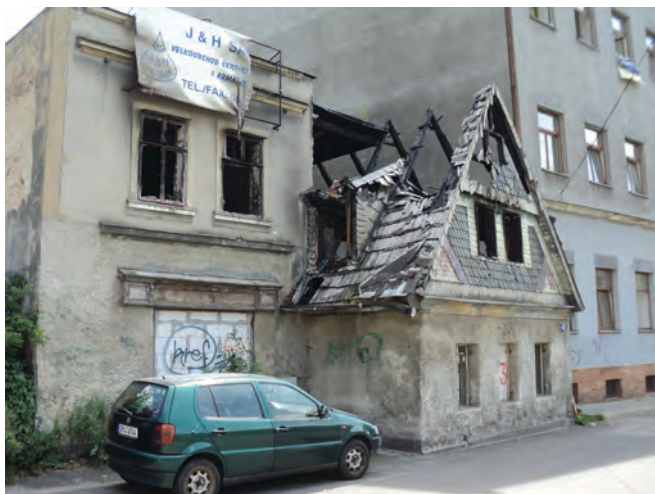
Obr. 13. Liberec, ulice Na svahu. Kontrastní situace předměstské zástavby venkovského rázu se dvěma generacemi obytných nájemných domů 19. stol. Dokumentární postupy odpovídají v takovém případě jednotlivým typologickým druhům ve srostlici, tedy v podstatě lidové architektuře a městskému nájemnému domu.
